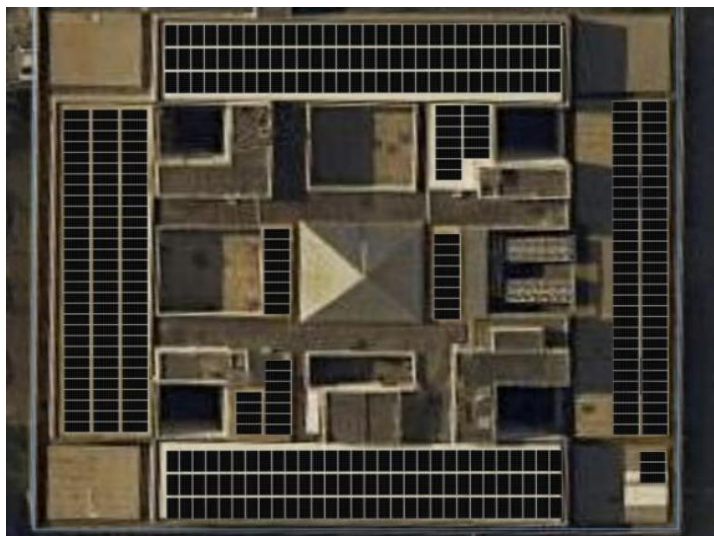
Coberturas – Projeção onde serão instaladas as placas fotovoltaicas.
