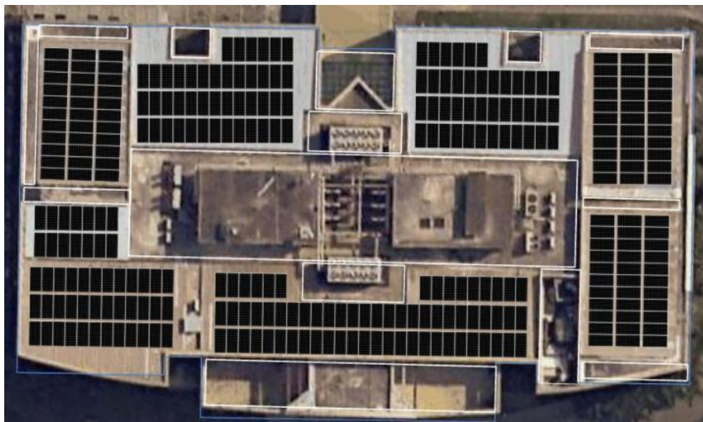
Coberturas – Projeção onde serão instaladas as placas fotovoltaicas.
