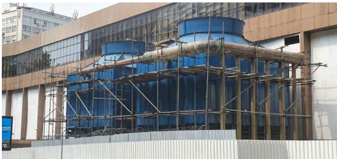
Torres de arrefecimento provisórias do Sistema de Refrigeração
