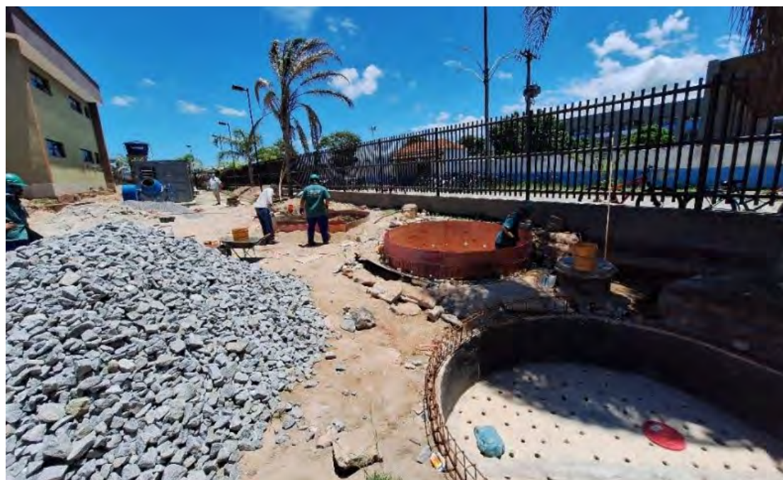
Sistema de Tratamento: Tanque Séptico e Filtros Anaeróbios
