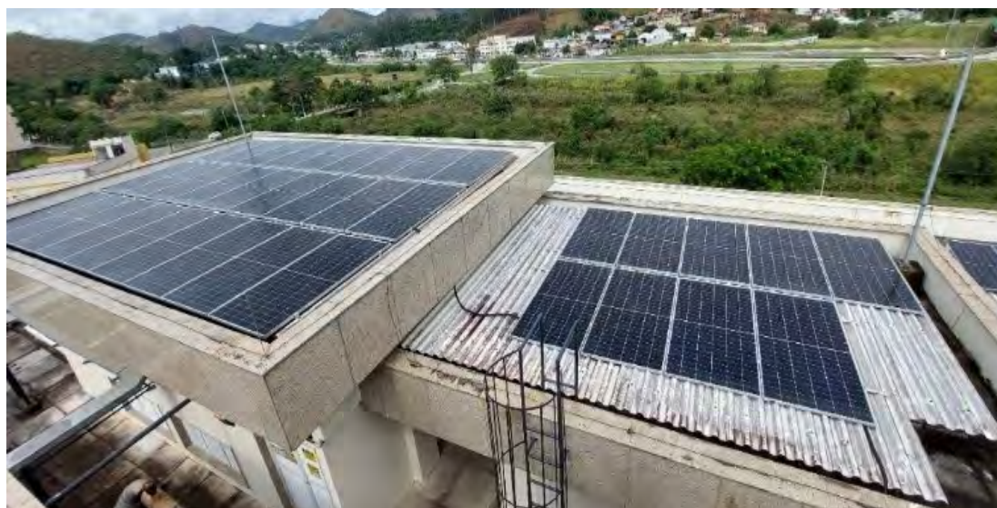
Placas fotovoltaicas instaladas
