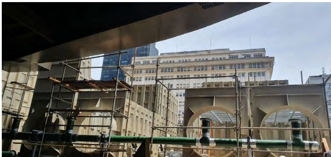
Fase atual da montagem das novas Torres de Refrigeração de Água
