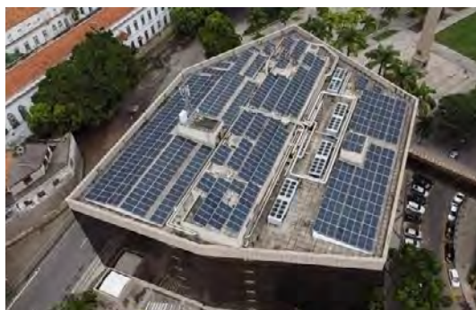
Placas fotovoltaicas instaladas
