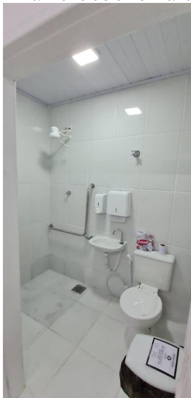
FOTO 29 – Banheiro de enfermaria em obra
