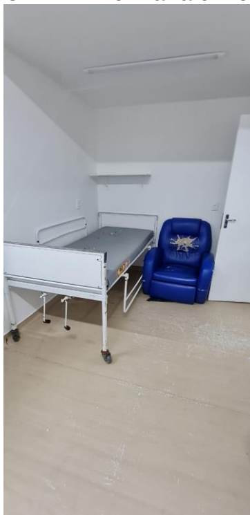
FOTO 27 – Enfermaria em obras
