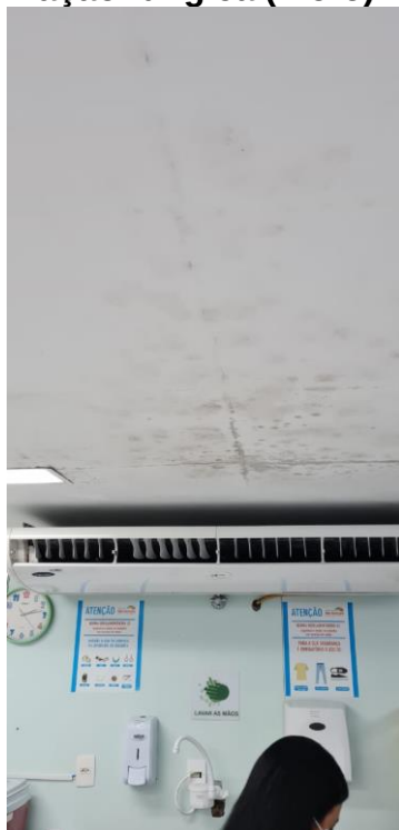
FOTO 51 – UI neonatal - colonização fúngica (mofo) no interior de suas instalações
