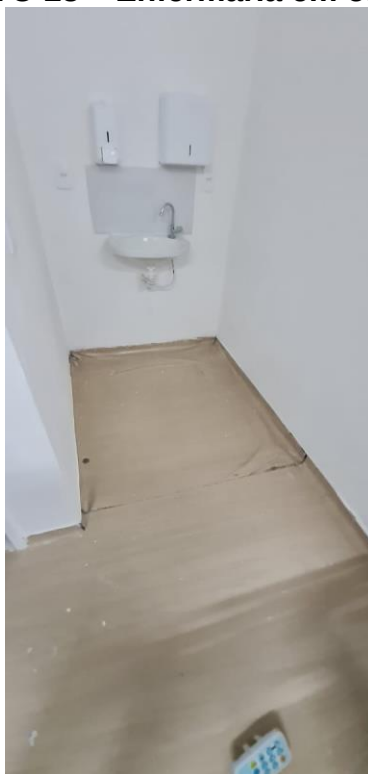
FOTO 28 – Enfermaria em obras
