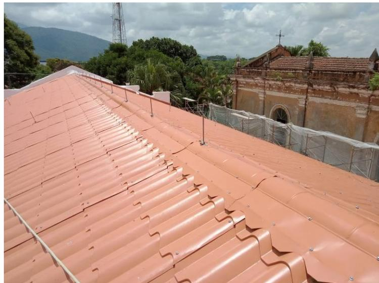
*Telhas termoacústicas com instalação de SPDA*
