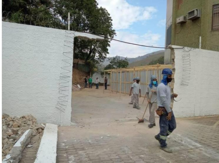
*Demolição de parte do muro existente para acesso de veículos e máquinas ao interior do canteiro de obras*
