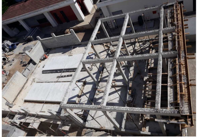
Vista superior da estrutura da nova central de água gelada
