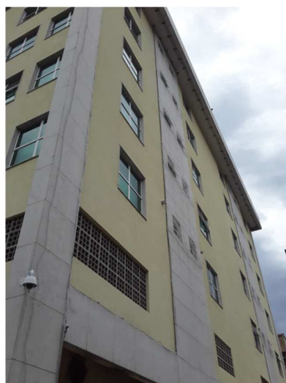
Proteção das fachadas com revestimento em granito
