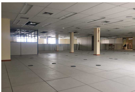
Execução de forro removível em fibra mineral, piso elevado, instalações elétricas e especiais e sistema de climatização nas áreas novas
