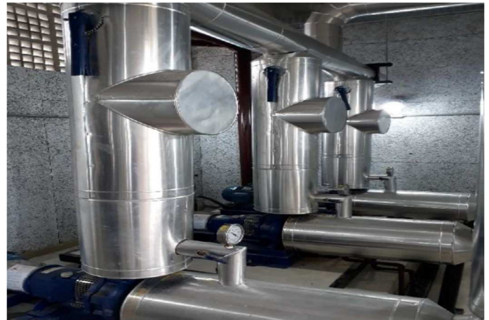
Bombas com isolamento na central e água gelada
