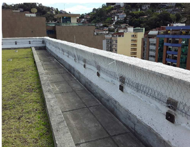
Proteção das platibandas na cobertura
