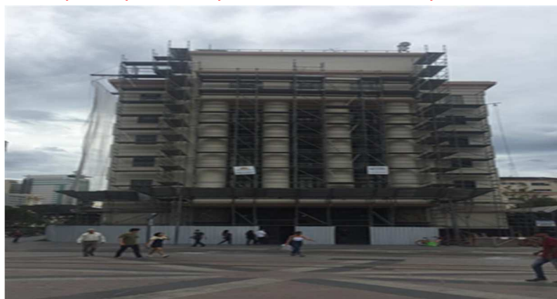
Execução de pintura das fachadas principal, lateral da Baía de Guanabara e Boulevard
