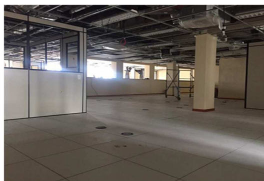
Execução de forro removível em fibra mineral, piso elevado, instalações elétricas e especiais e sistema de climatização nas áreas novas
