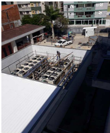
Novos Chillers instalados
