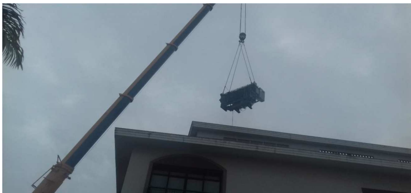
Içamento com guindaste para retirada dos equipamentos substituídos da cobertura
