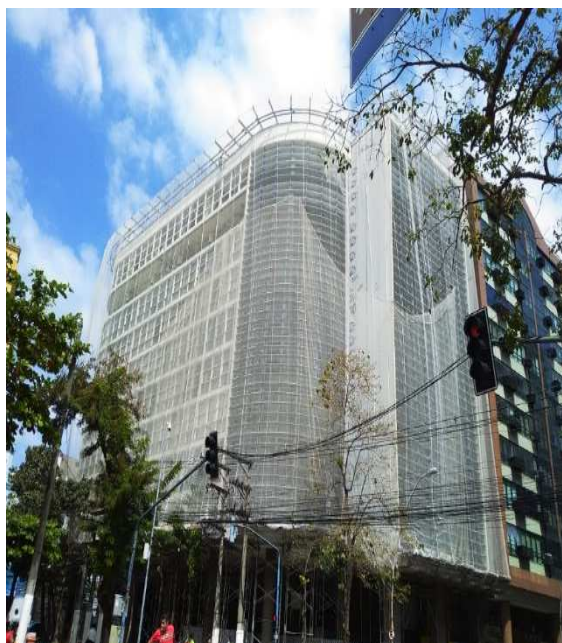
Durante a obra substituição das esquadrias
