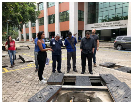
Finalização da obra com a demonstração da contratada da operação do sistema
