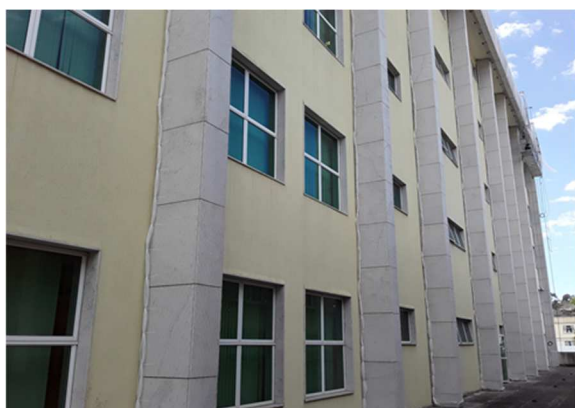
Proteção dos pilares
