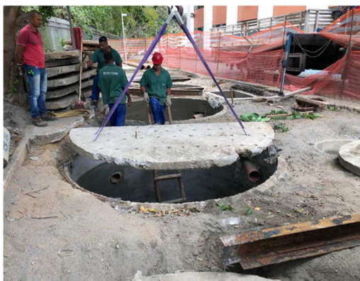
Recuperação dos filtros da ETE
