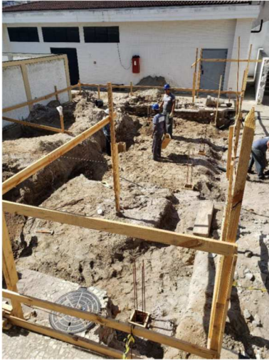
Fundação da sala do operador, casa de bombas e sala de quadros
