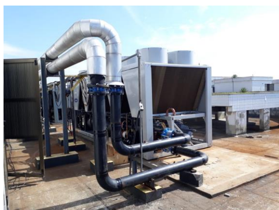
Serviços de instalação dos chillers
