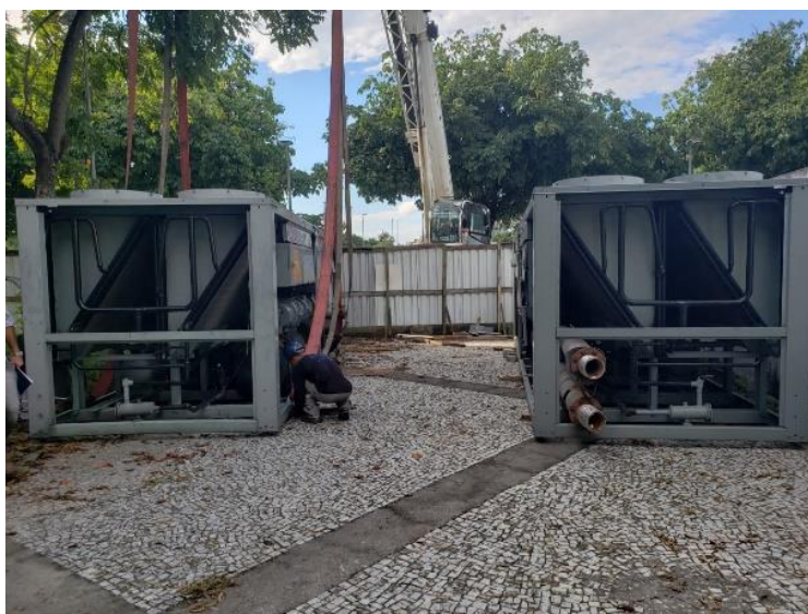
Equipamentos antigos removidos
