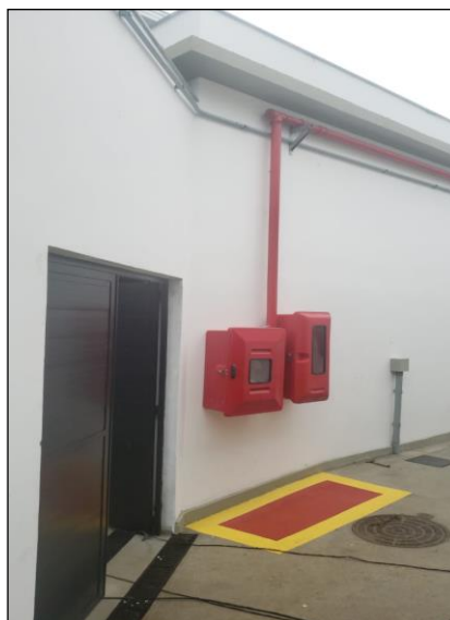
Nova rede e caixas de incêndio
