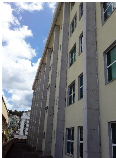
Proteção da fachada dos Fundos
