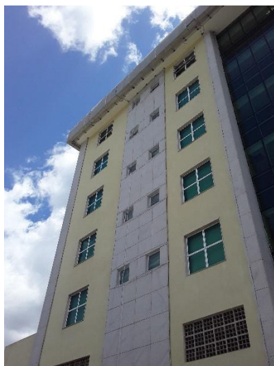
Proteção da fachada Prefeitura
