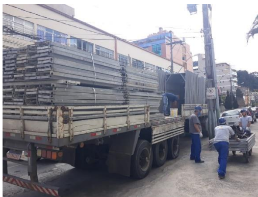
Recebimento de andaime fachadeiro
