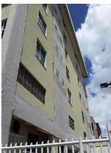
Proteções da fachada principal
