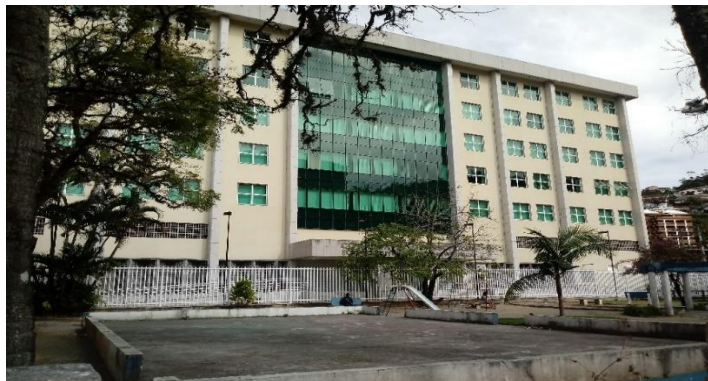
Fachada a ser recuperada
