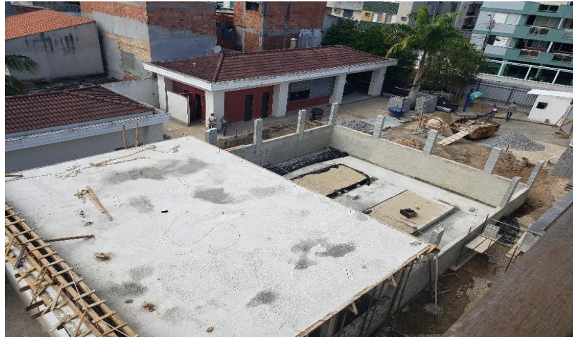
Vista superior da casa de bombas, sala do operador e base do chillers
