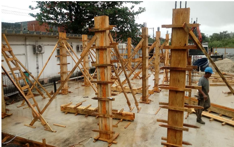
Estrutura da ampliação do Centro Integrado de Videoconferência
