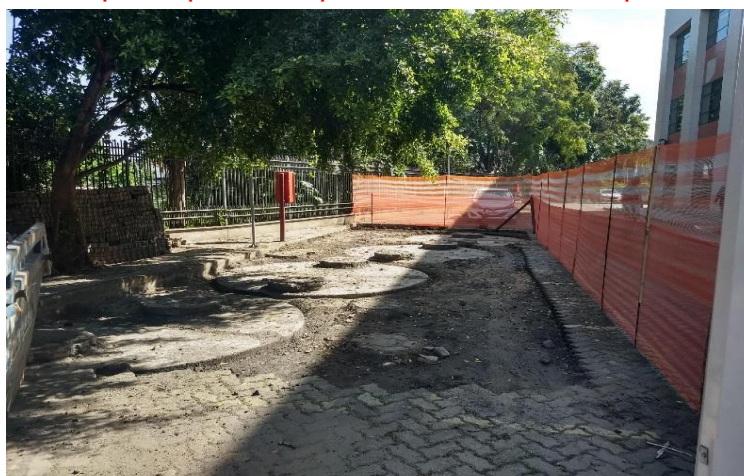
Início dos trabalhos, retirada do piso intertravado
