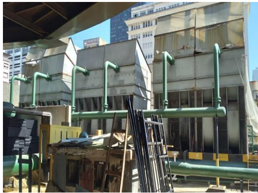
Torres de arrefecimento a serem substituídas.
