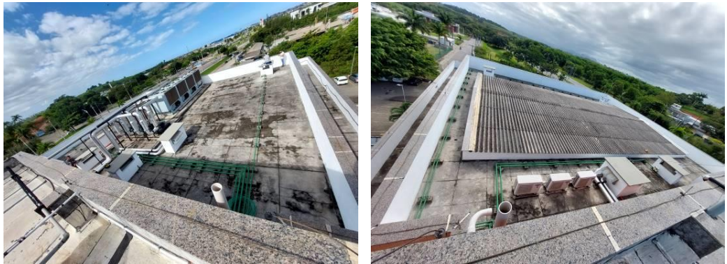
Cobertura – Local onde serão instaladas as placas fotovoltaicas.
