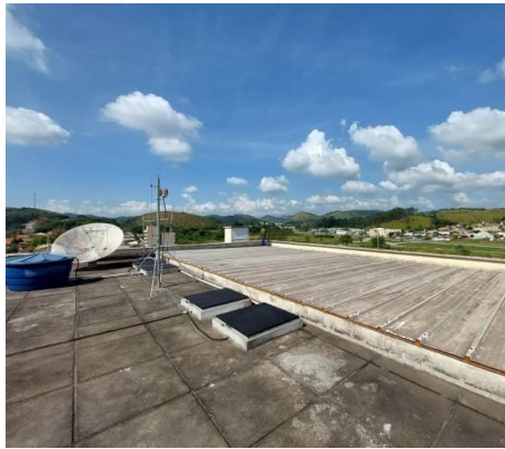
Coberturas – Local onde serão instaladas as placas fotovoltaicas.
