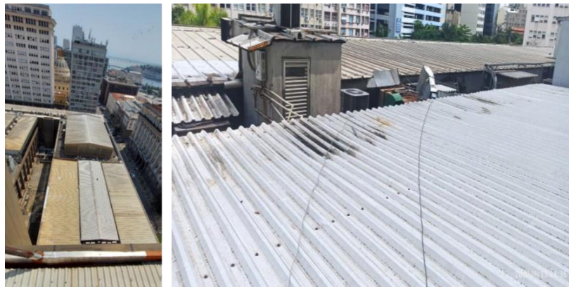
Coberturas – Local onde serão instaladas as placas fotovoltaicas.
