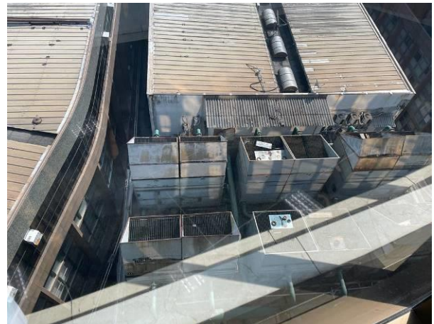
Torres de arrefecimento a serem substituídas.
