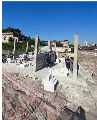
Execução da Subestação.
