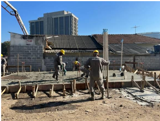
Execução da cantina.
