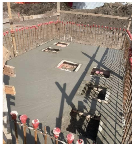
Execução de Reservatório.
