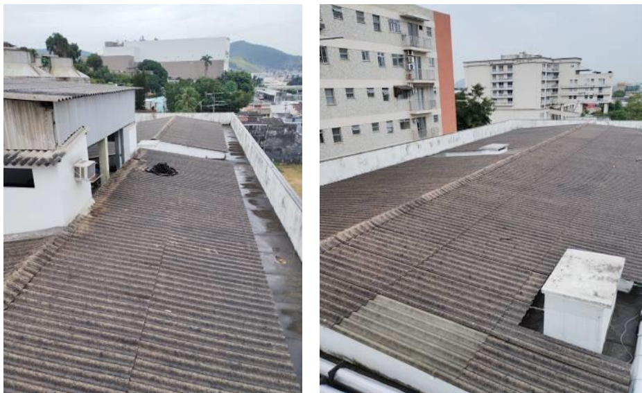
Coberturas – Local onde serão instaladas as placas fotovoltaicas.
