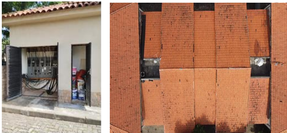
Cobertura – Local onde serão instaladas as placas fotovoltaicas.
