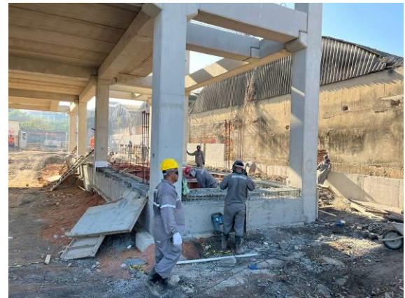
Execução das vigas moldadas in loco.
