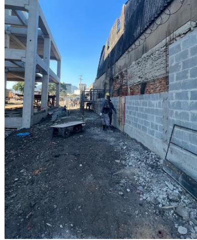
Execução do muro de divisa.
