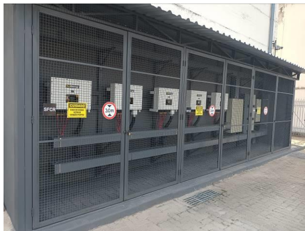
Instalação das placas fotovoltaicas.
