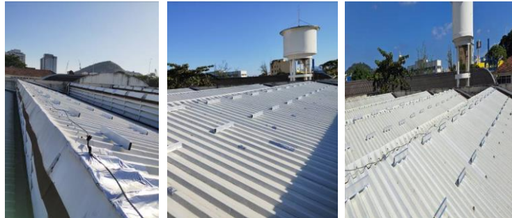
Coberturas – Local onde serão instaladas as placas fotovoltaicas
