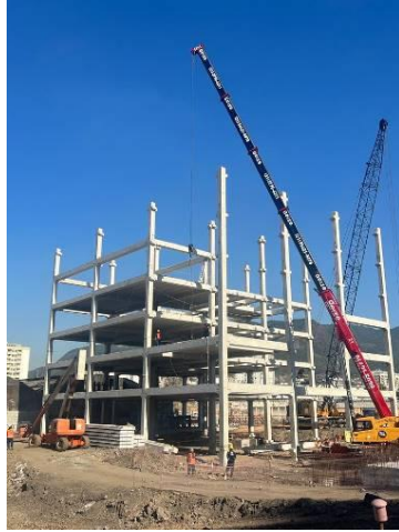
Montagem dos pilares, vigas e lajes pré-moldadas do prédio do VEMSE.
