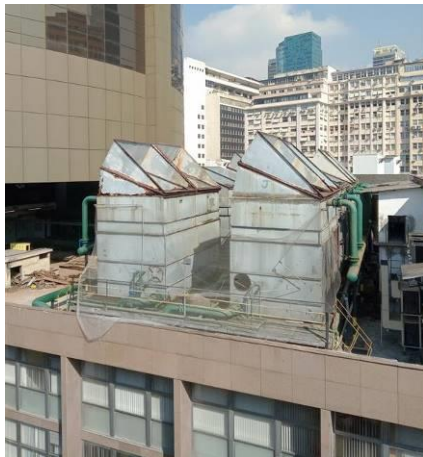
Torres de arrefecimento a serem substituídas.
