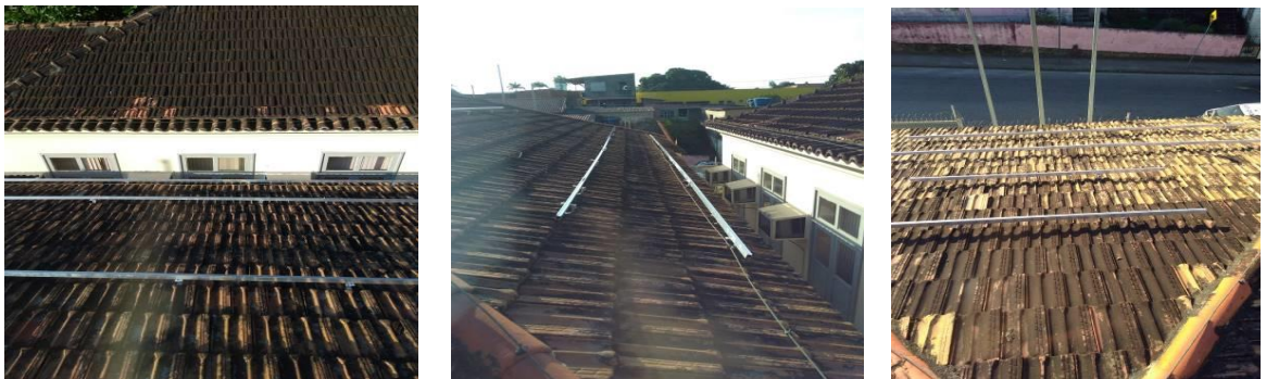
Coberturas – Local onde serão instaladas as placas fotovoltaicas.
