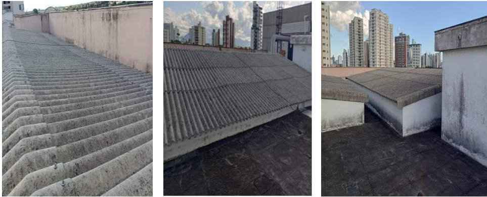
Coberturas – Local onde serão instaladas as placas fotovoltaicas.
