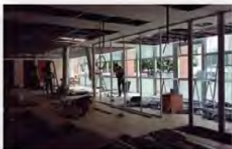
Corredor B – 2º Pavimento Serventia
