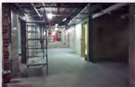
Corredor C – 2º Pavimento Circulação
