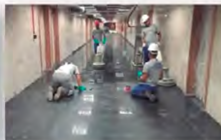
Corredor D – 3º Pavimento Circulação
