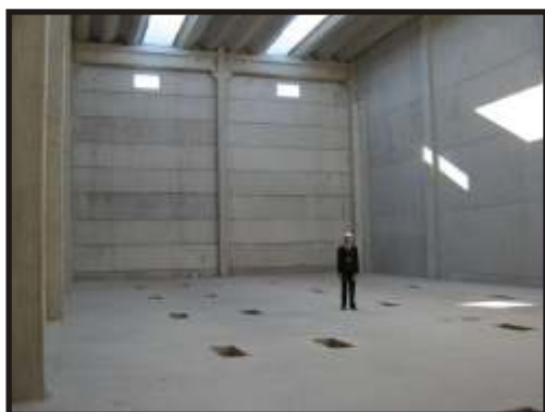
Um dos dois galpões (Centros de Informação) em construção
