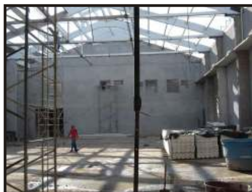
Visão de parte da área administrativa
