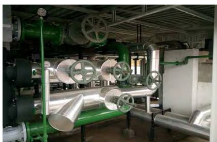
Instalação do Chiller
