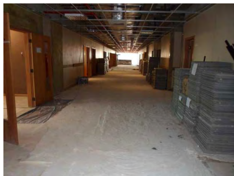
Revisão dos telhados da cobertura 1. Proteção em gesso do piso do Fórum.
