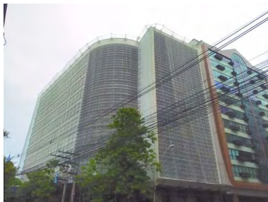
Fachada com tela de proteção.
