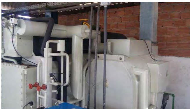
Chiller novo no local
