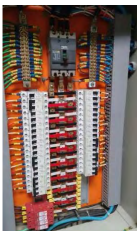
Revisão dos quadros elétricos. Complementação do Plaqueamento (cobertura 1). Proteção do Piso.
