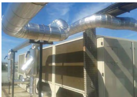
Chiller novo (Comarca de Macaé)
