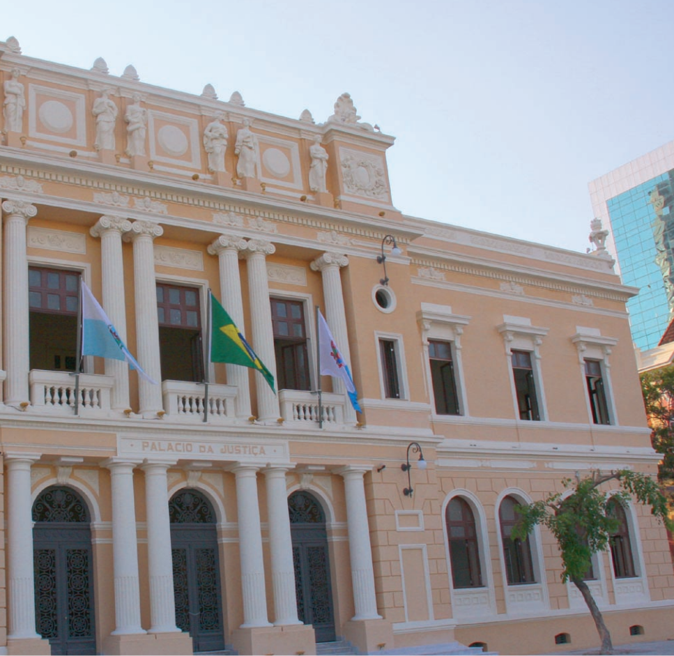
Fachada do Palácio da Justiça de Niterói, após a restauração
